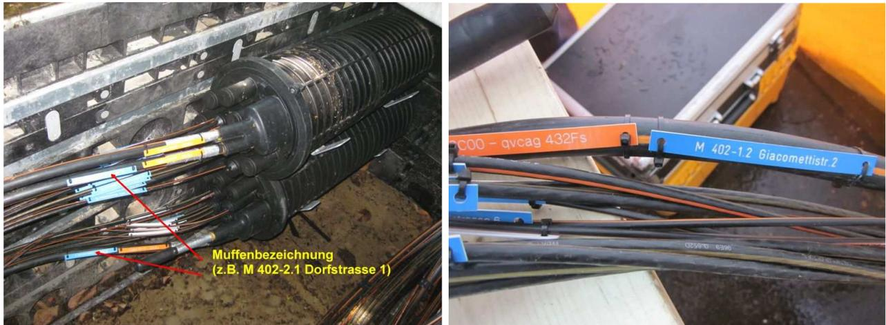
Abbildung 87 Muffenbeschriftung
