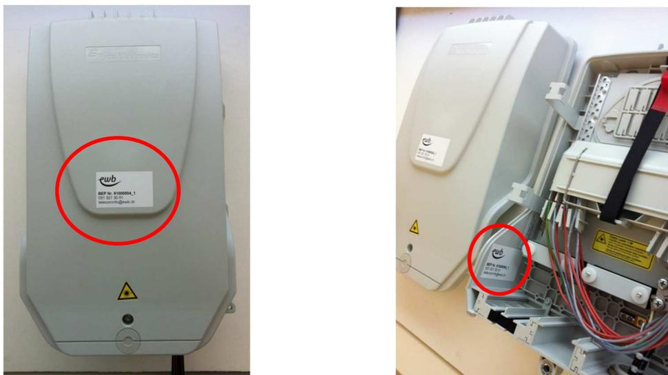
Abbildung 82 BEP inkl. Beschriftung (Li: Aussendeckel; Re: innerhalb des BEP-Gehäuses)
