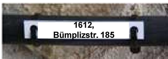
Abbildung 96 Kabelbeschriftungsschild für Drop-Kabel (bei BEP)
