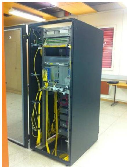
Abbildung 68 Milegate Equipment in bestehendem Rack im CO BRE
