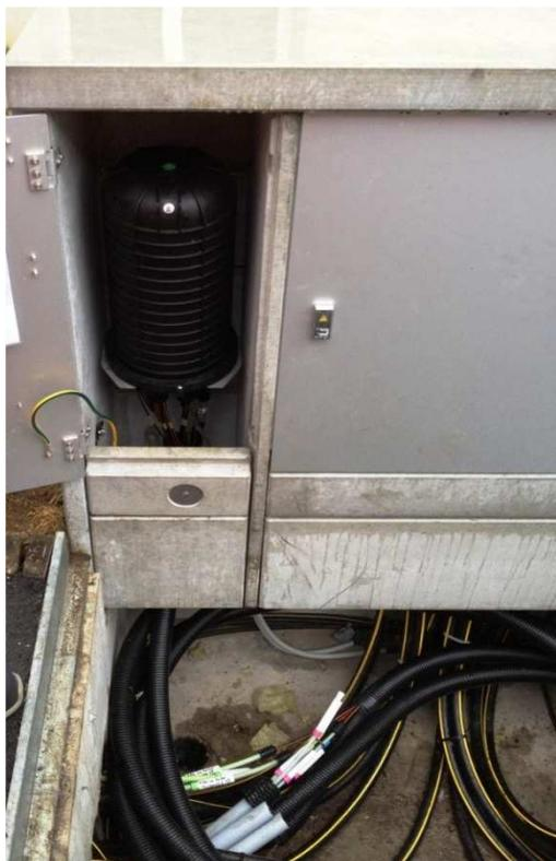
Abbildung 44 FTTH-Kabel in VK-Vorschacht in separatem Kabelschutzrohr
