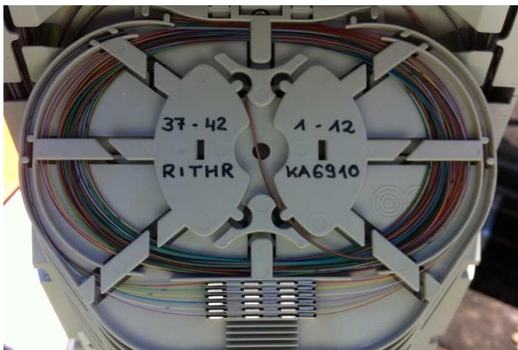
Abbildung 120 Reihenfolge Spleissungen in Kassette
