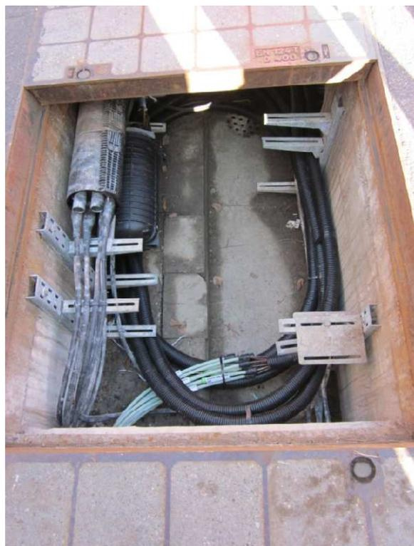
Abbildung 114 Beispiel einer Verlegung in einem Swisscom-Schacht
