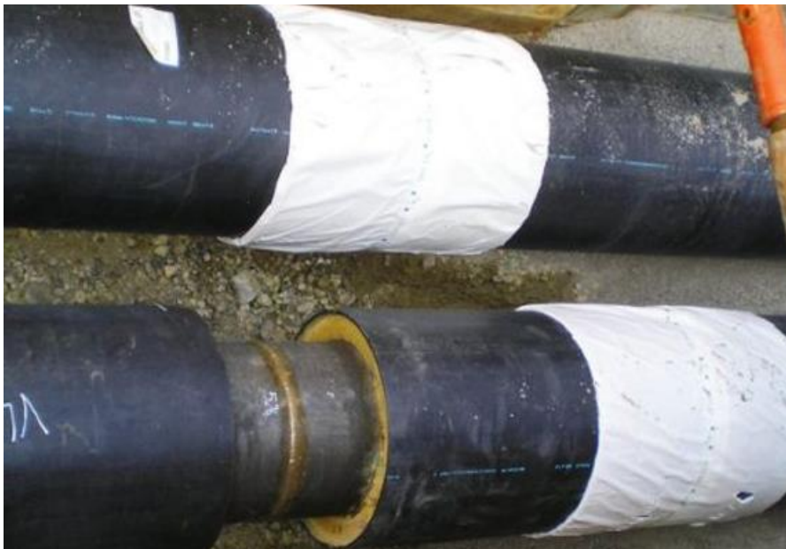
Abbildung 21: Muffenverbindung (Quelle Brugg Pipes)
