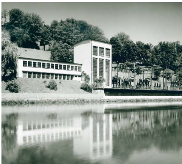
Das Unterwerk Engehalde kurz nach seiner Inbetriebnahme – bereits damals ein zentrales Element der Stromversorgung für die Stadt Bern.
