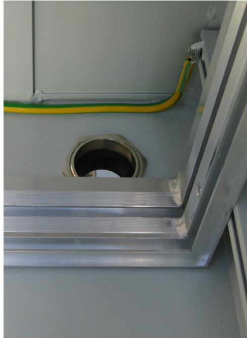
Einführung des Installationskabels
