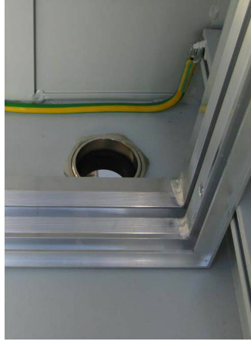
Einführung des Installationskabels
